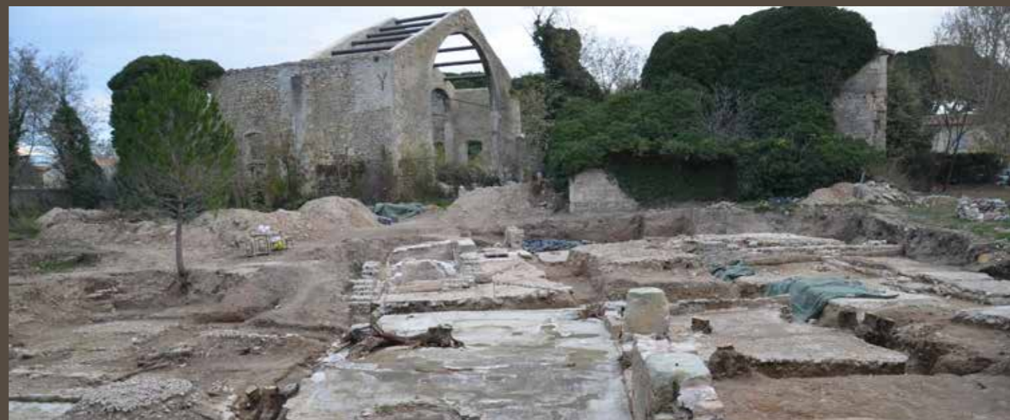
Vue des vestiges à l'achèvement du chantier le 2 décembre 2013 © A. Genot, M.-P. Rothé, CD13 / MDA.
