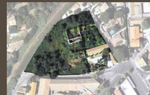
Vue aérienne du site de la Verrerie avant son dégagement © ACCM : BDU.
