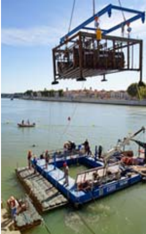
Chantier Arles Rhône 3 le levage/ Copyright – Rémi Benali – Cg13
